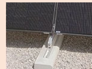
Poteaux béton (type clôture)
